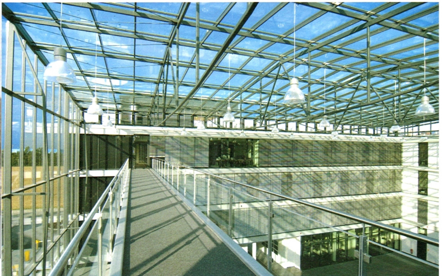
Das Atrium am Standort der BrainLab AG in Feldkirchen: Letztlich löste eine Heat-Stop-Folie von Suncoat das Dilemma aus Tageslichtbedarf und Hitzeentwicklung.
